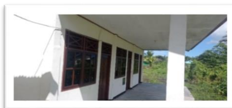
Gambar 9. Ruang Osis, Laboratorium IPA, dan Laboratorium Fisika
